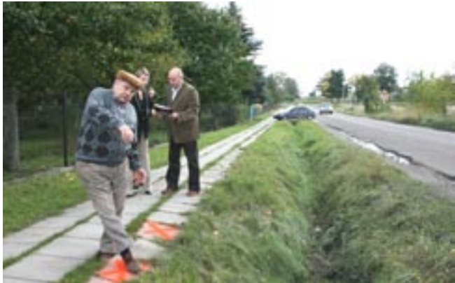
Woda stojąca w rowie na skutek zaślepienia przepustu niszczy chodnik, który miejscami zaczyna się zapadać. Aby zapobiec wypadkowi, mieszkańcy zaznaczyli sprejem najbardziej niebezpieczne odcinki
