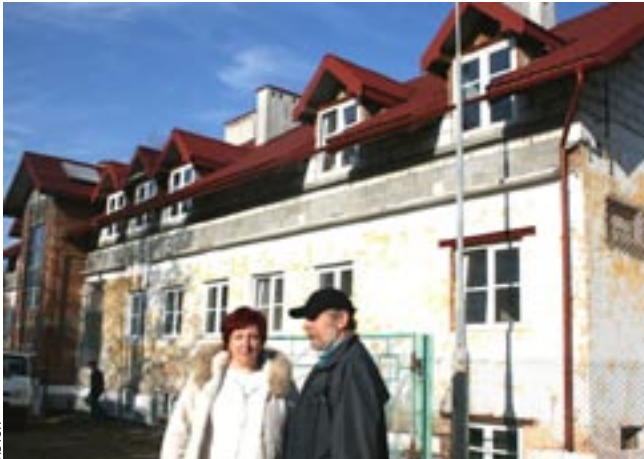
Albertyńscy społecznicy pieczołowicie doglądają końcowych prac remontowych przy obiekcie hospicjum. Na zdj. Alicja Kocyłowska i Andrzej Wanielista podczas jednej z codziennych wizyt.
